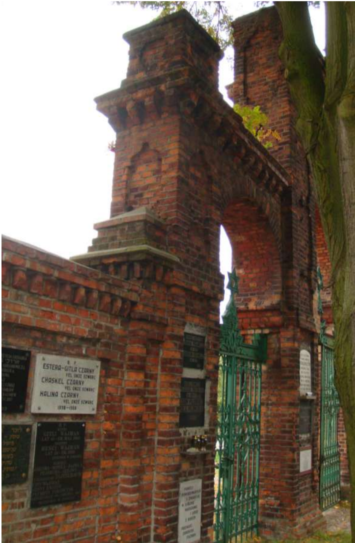
Szkic 3 Widok bramy od strony południowo zachodniej
